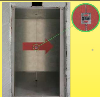
Posición de los enlaces térmicos o mecanismos de bulbo térmico en la corriente de aire para la medición del límite de temperatura umbral
